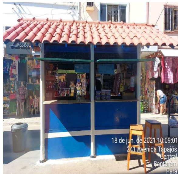
TELHADO E FACHADA
