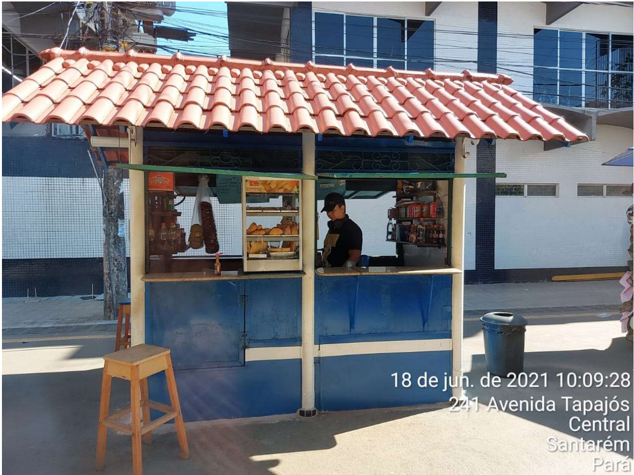
IMAGEM 01: Fachada principal do imóvel vistoriado
