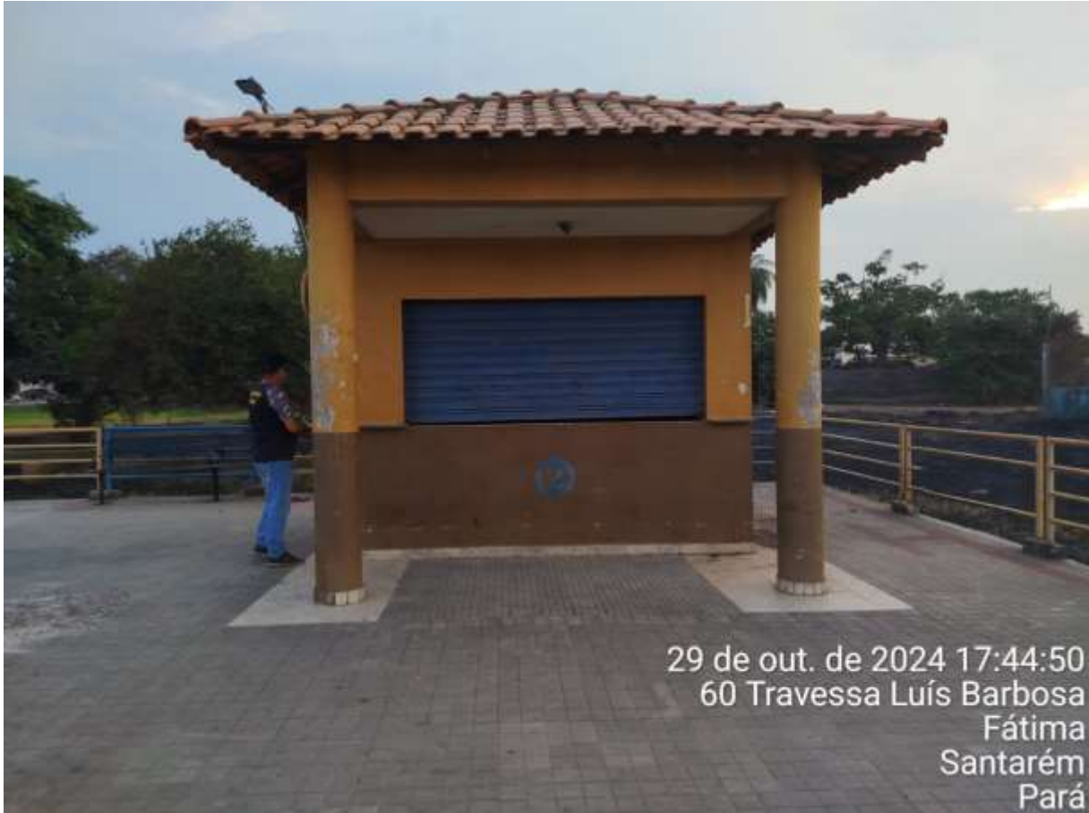
IMAGEM 01: Fachada principal do imóvel vistoriado
