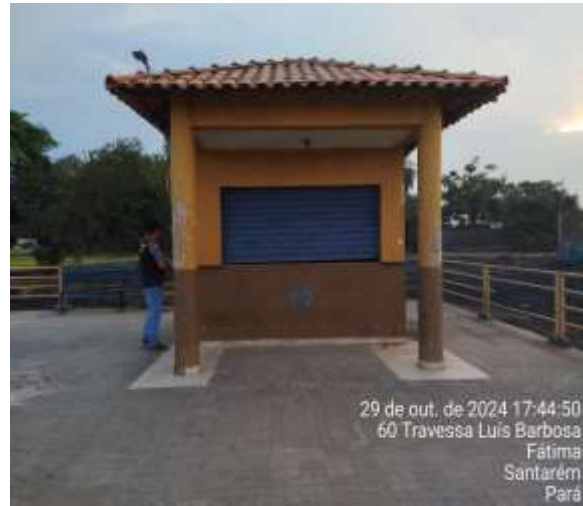
TELHADO E FACHADA
