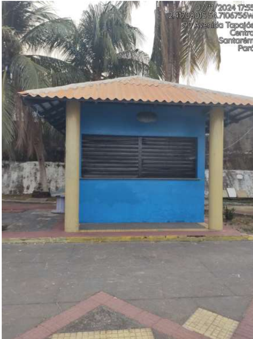
IMAGEM 01: Fachada principal do imóvel vistoriado
