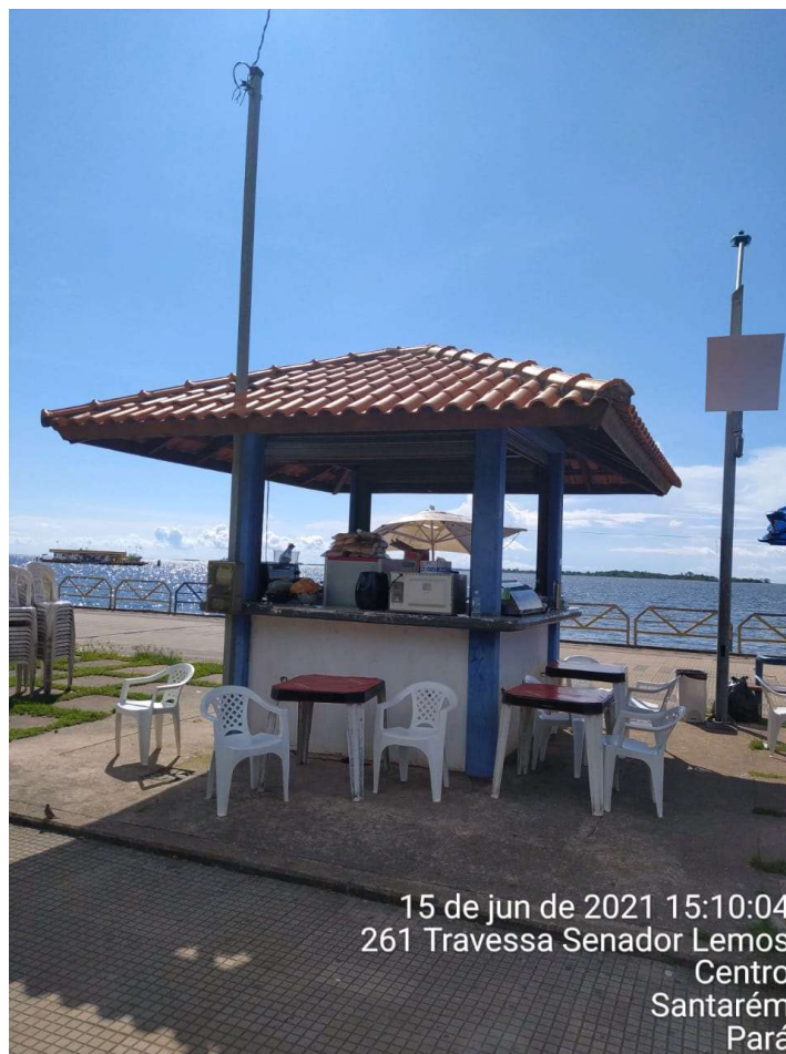
IMAGEM 01: Fachada principal do imóvel vistoriado
