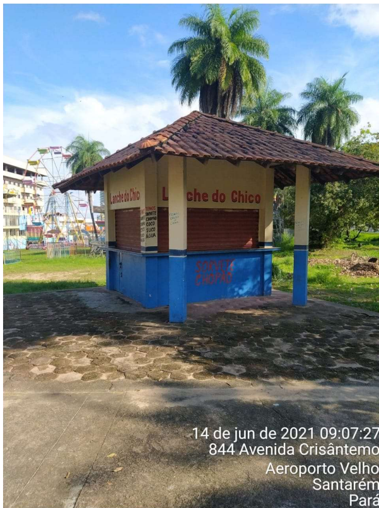
IMAGEM 01: Fachada principal do imóvel vistoriado
