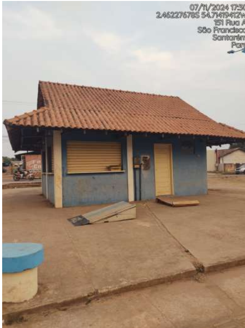
IMAGEM 01: Fachada principal do imóvel vistoriado
