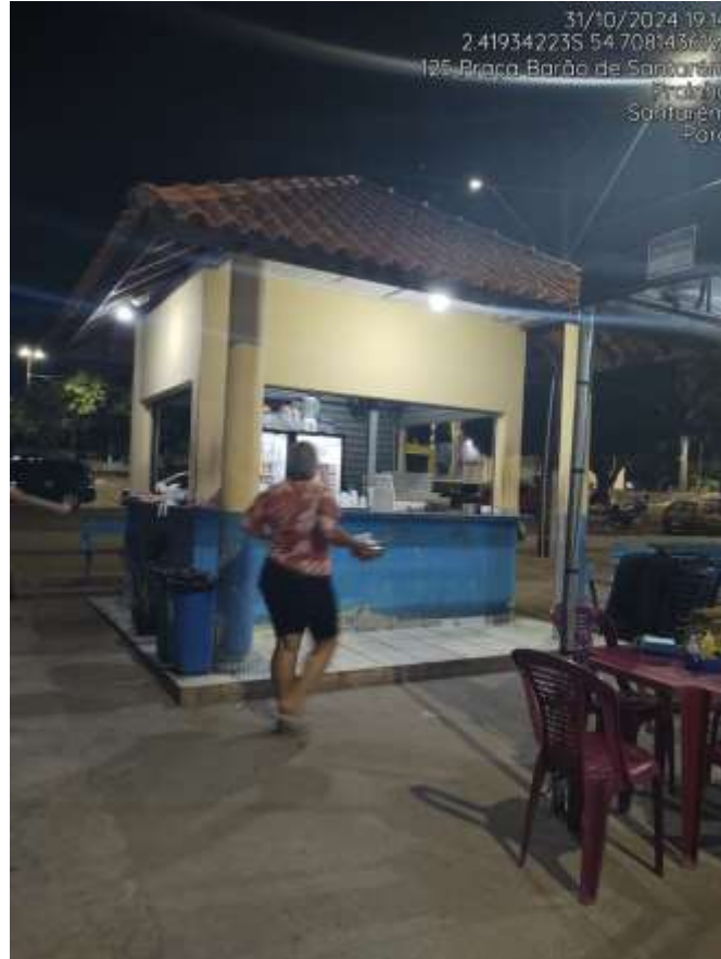
IMAGEM 01: Fachada principal do imóvel vistoriado
