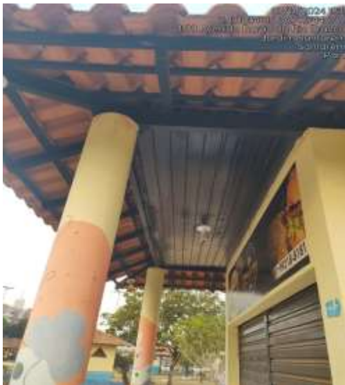
FORRO AREA EXTERNA
