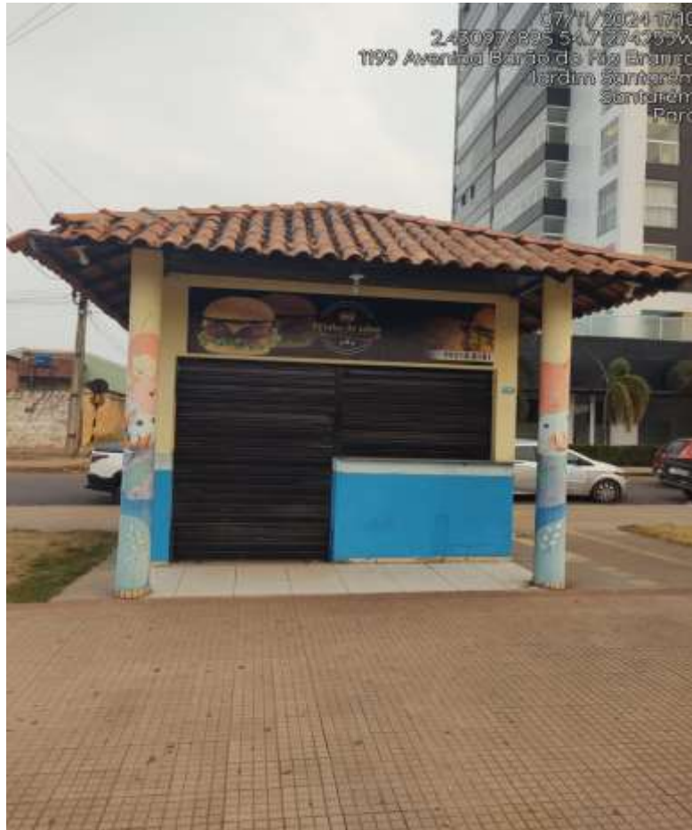
IMAGEM 01: Fachada principal do imóvel vistoriado
