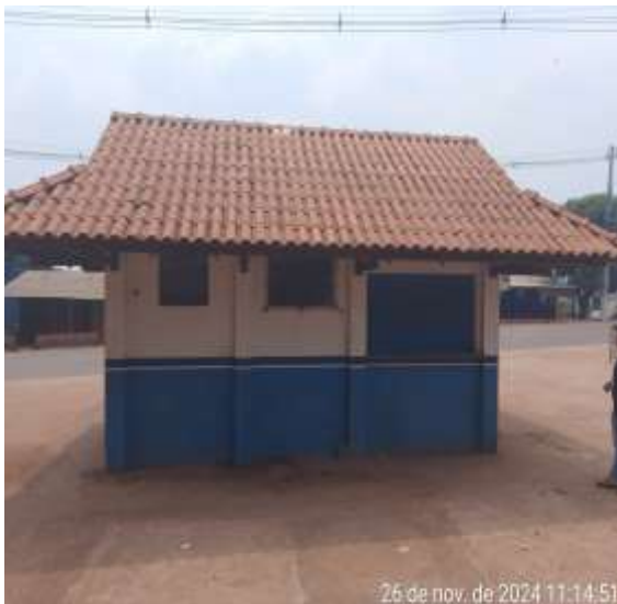
VISTA LATERAL TELHADO
