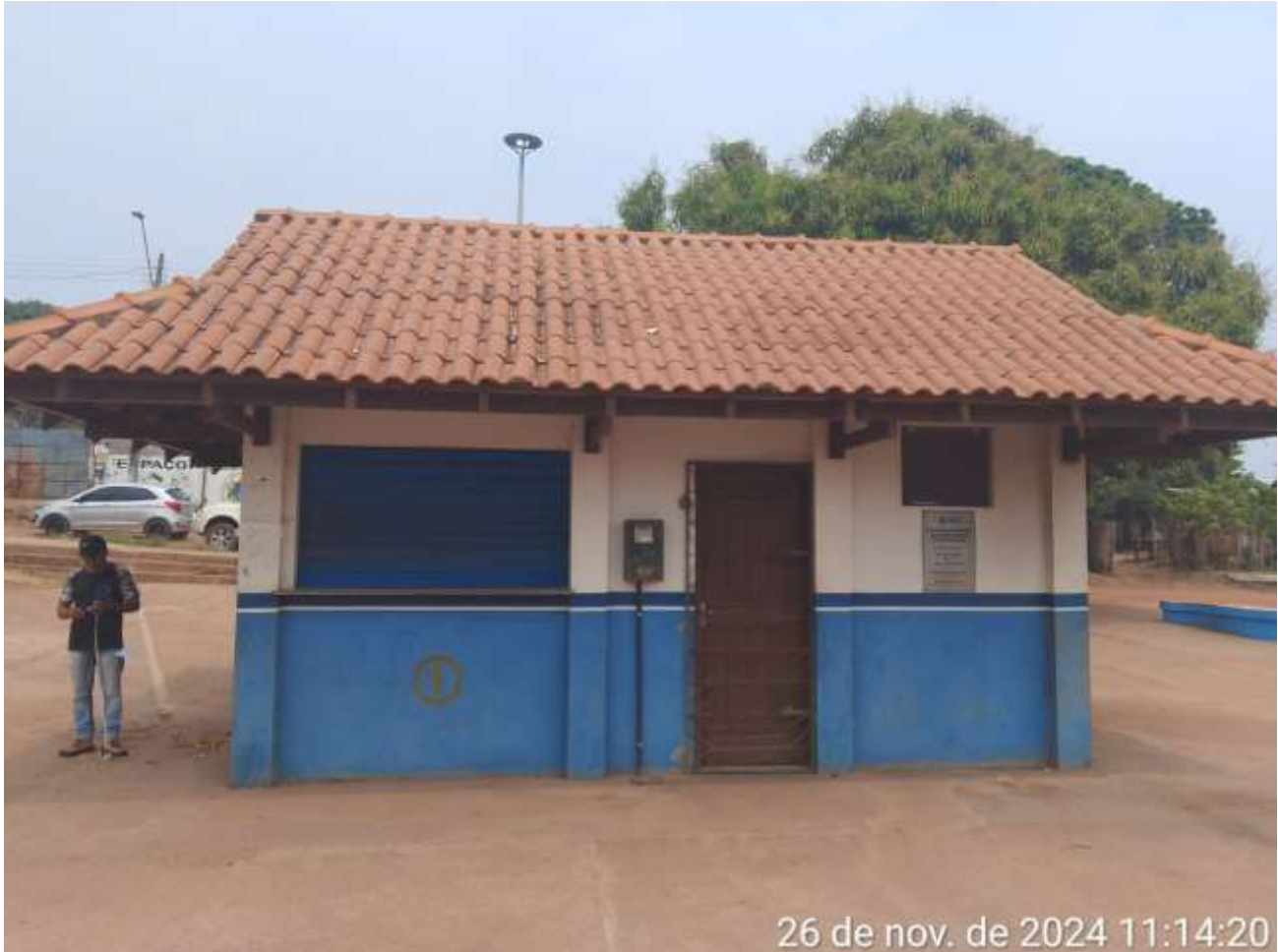
IMAGEM 01: Fachada principal do imóvel vistoriado
