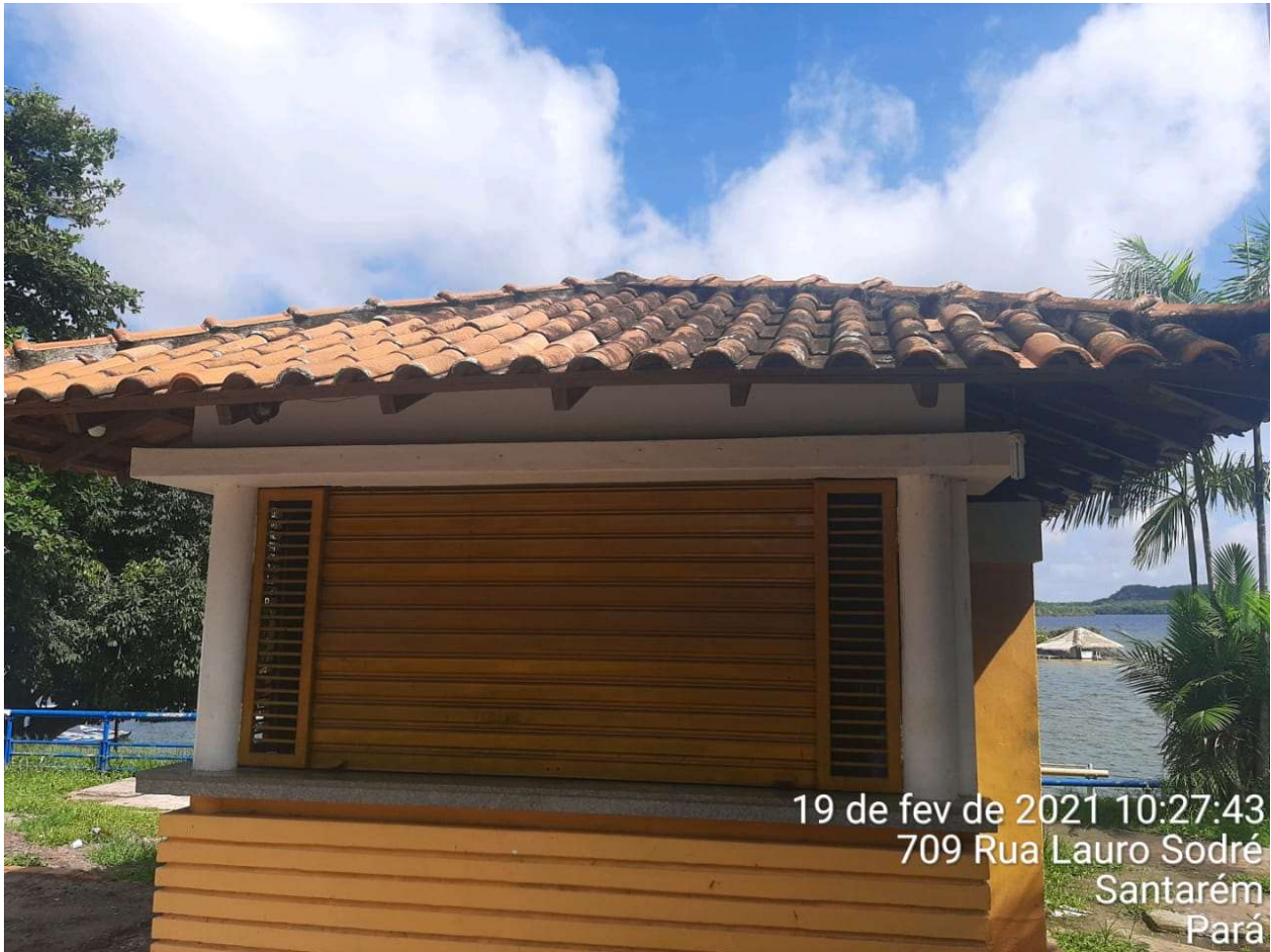
IMAGEM 01: Fachada principal do quiosque vistoriado
