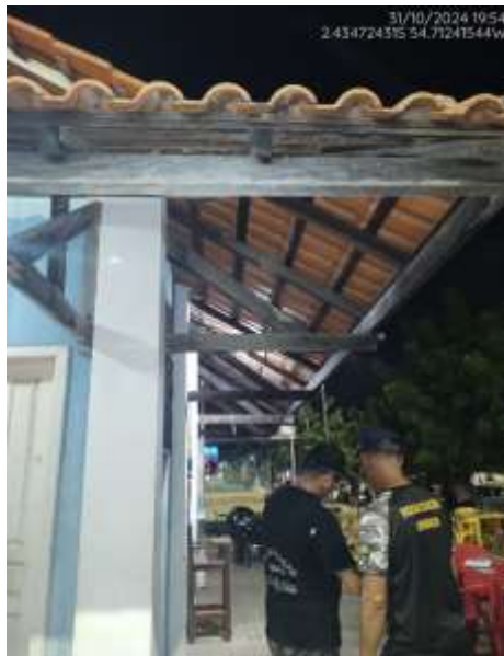
VISTA LATERAL TELHADO
