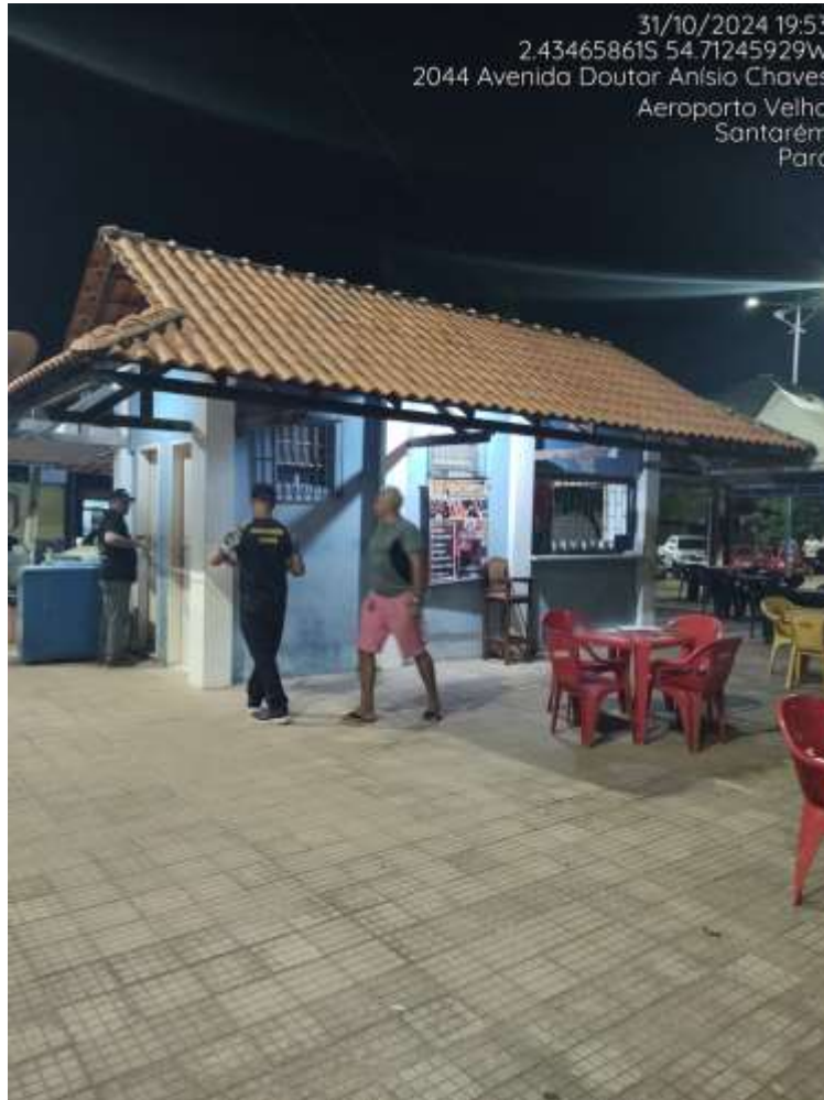
IMAGEM 01: Fachada principal do imóvel vistoriado
