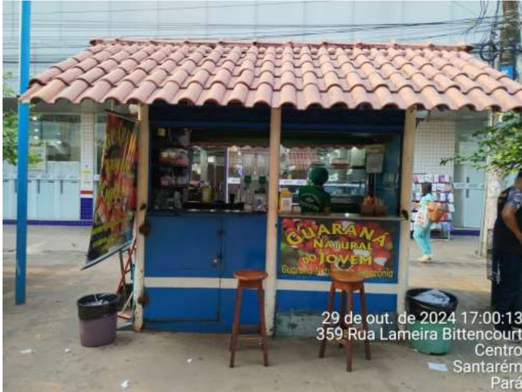
IMAGEM 01: Fachada principal do imóvel vistoriado
