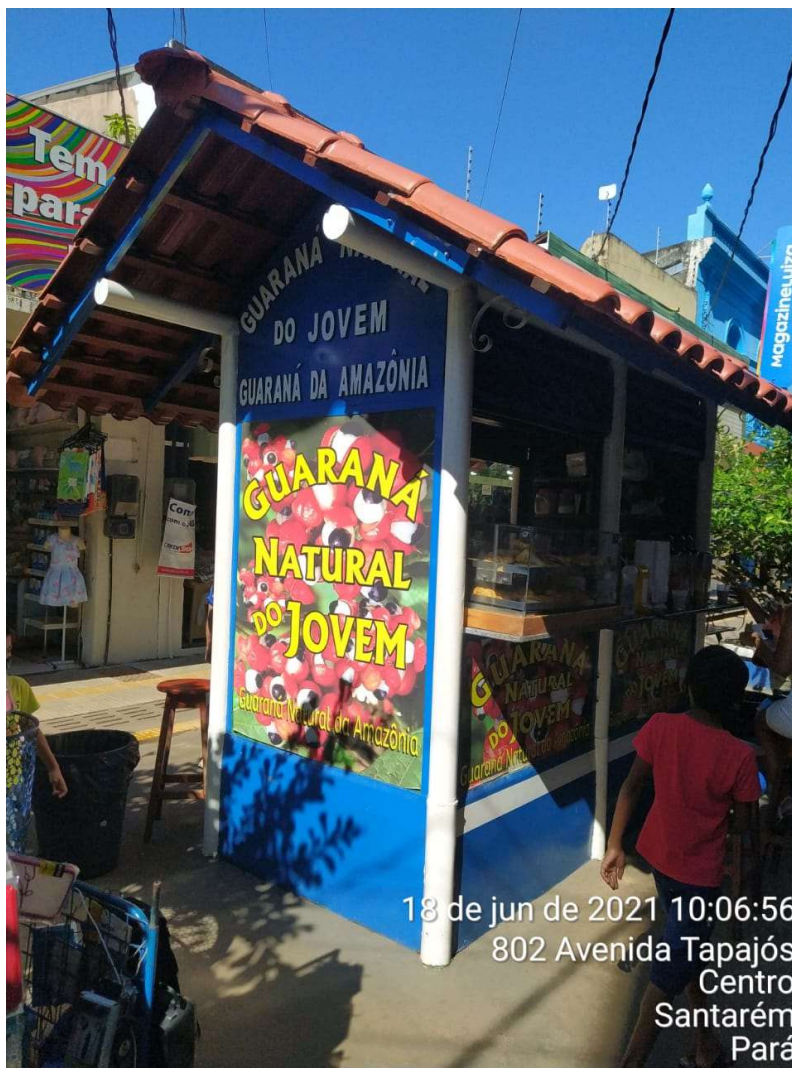
IMAGEM 01: Fachada principal do imóvel vistoriado
