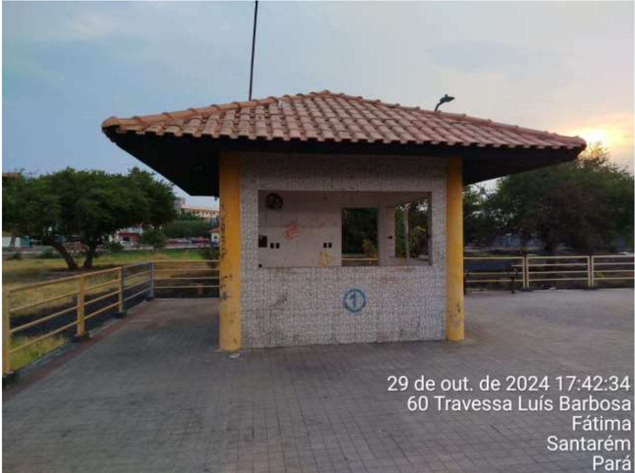
IMAGEM 01: Fachada principal do imóvel vistoriado
