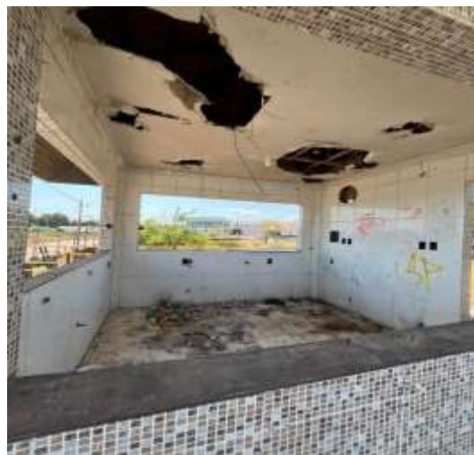
VISTA DAS PAREDES REVESTIDAS E FORRO
