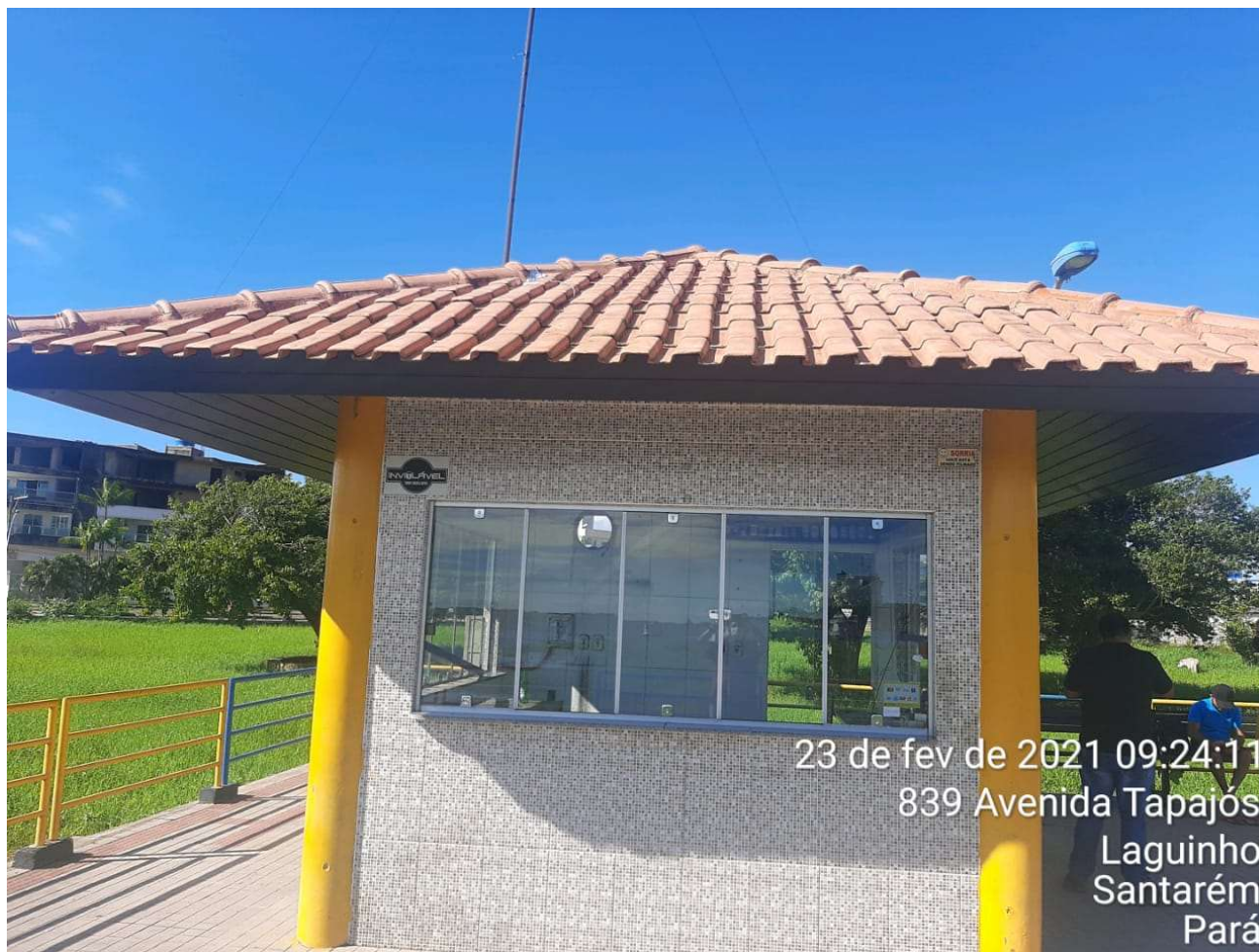
IMAGEM 01: Fachada principal do imóvel vistoriado
