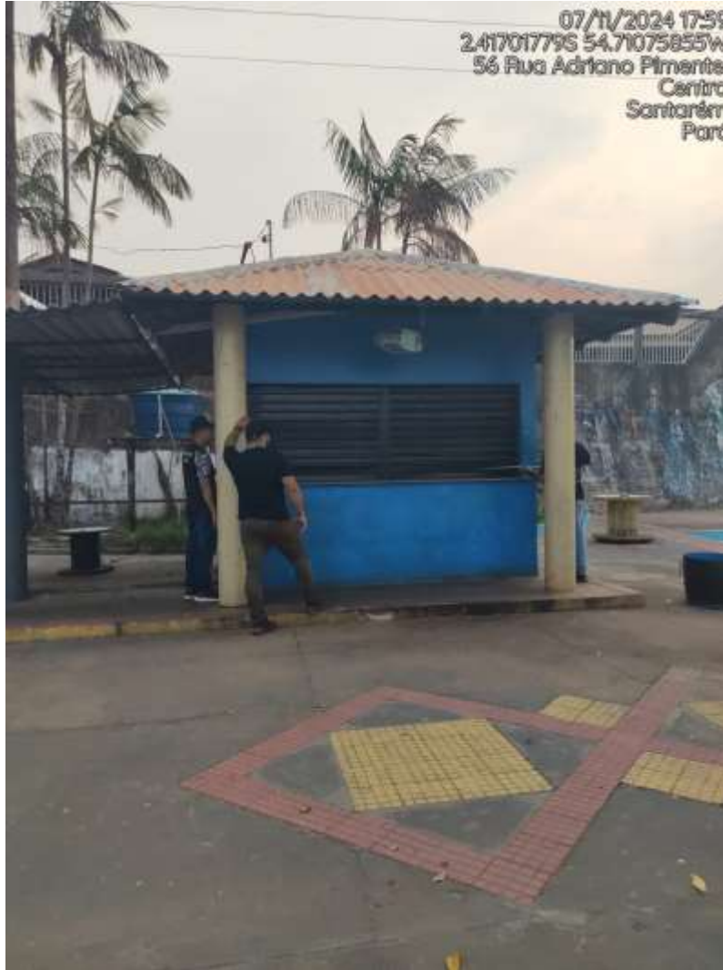
IMAGEM 01: Fachada principal do imóvel vistoriado
