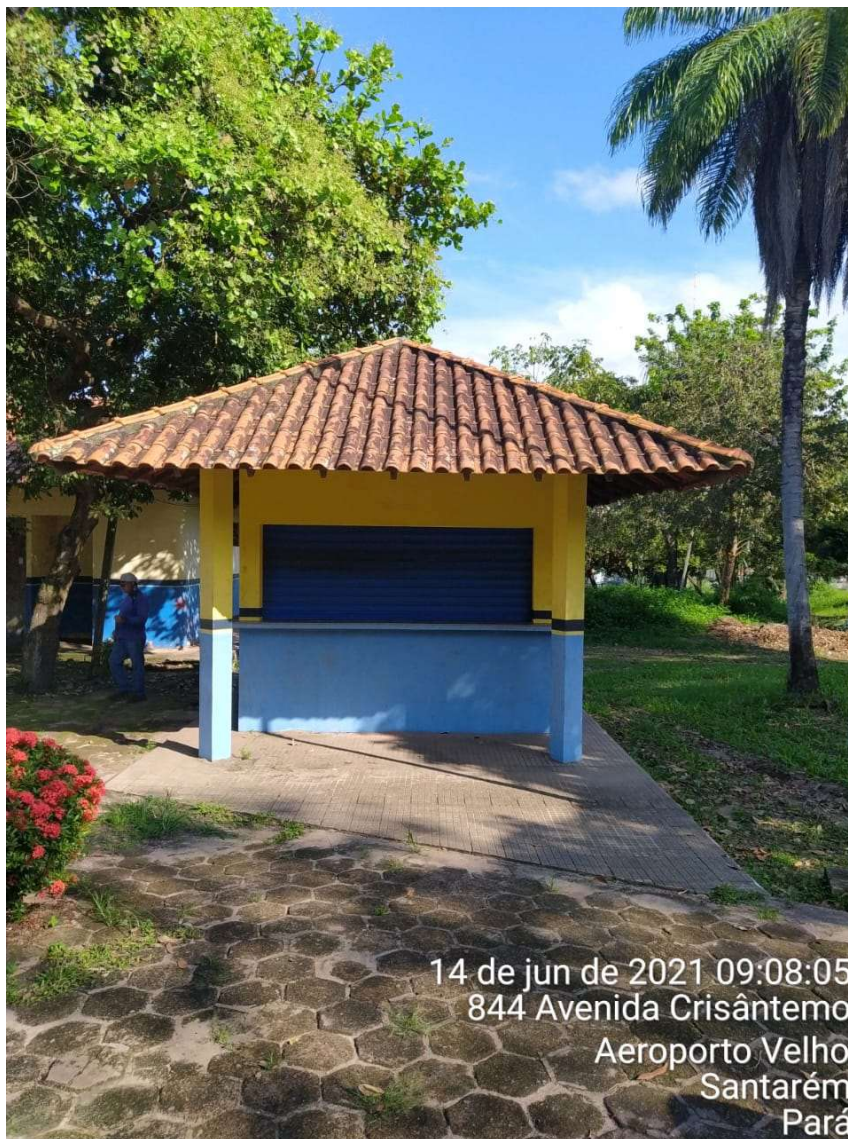
IMAGEM 01: Fachada principal do imóvel vistoriado
