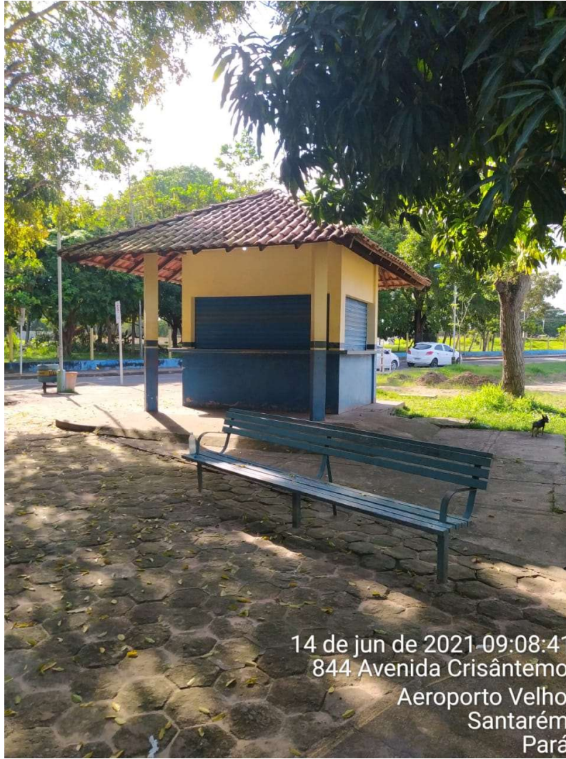
IMAGEM 01: Fachada principal do imóvel vistoriado
