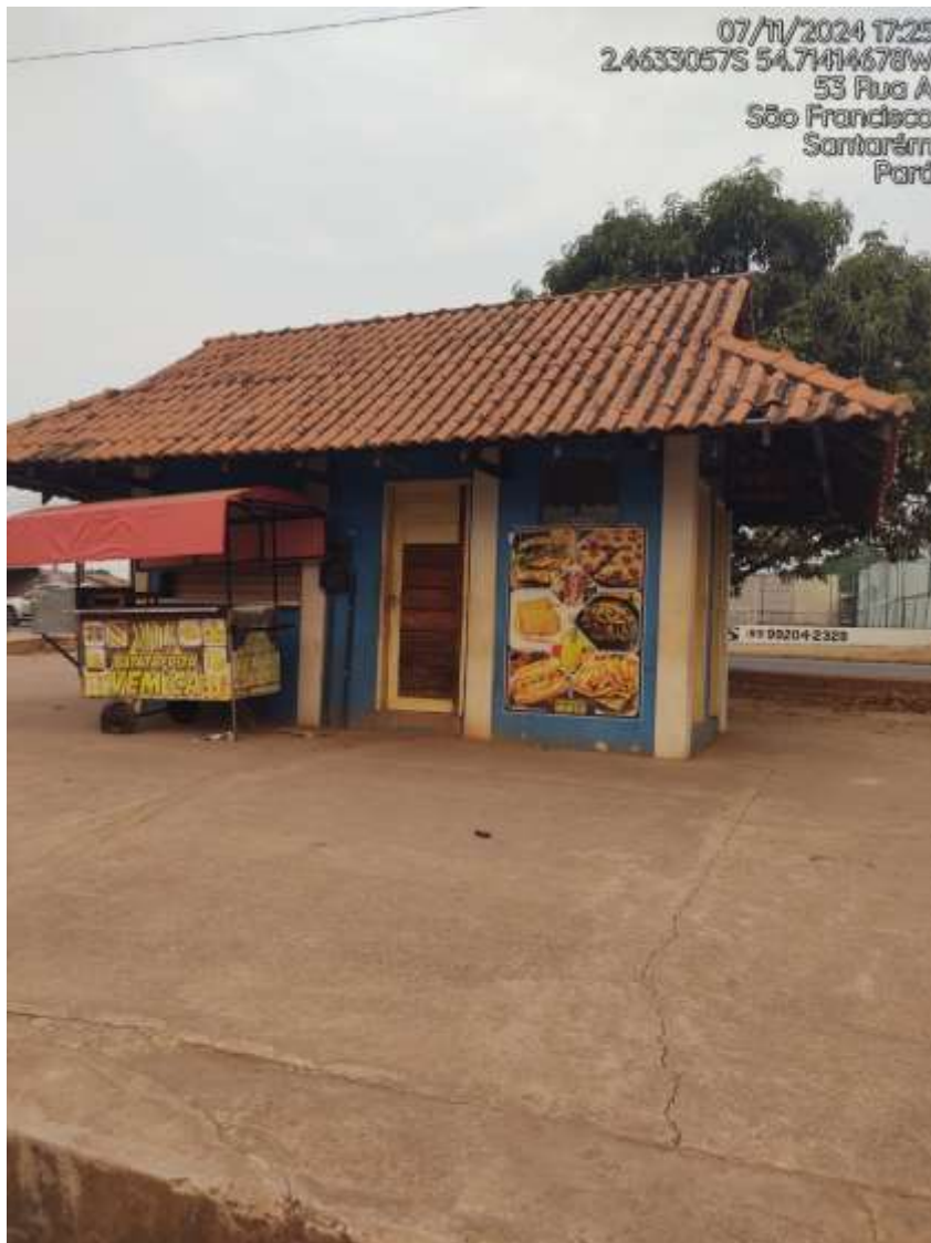
IMAGEM 01: Fachada principal do imóvel vistoriado
