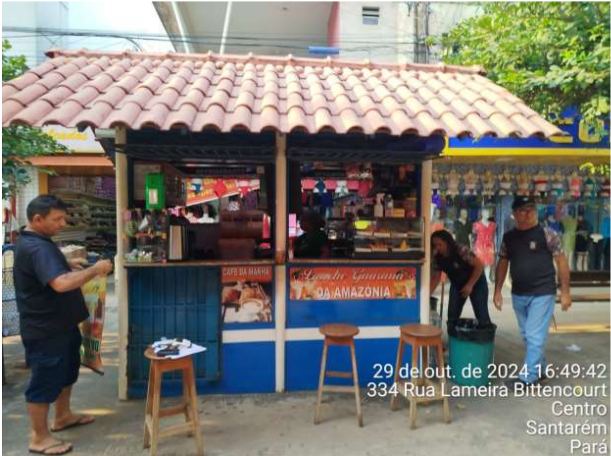
IMAGEM 01: Fachada principal do imóvel vistoriado
