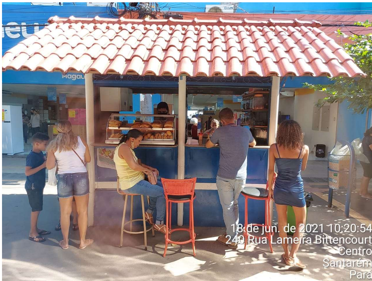
IMAGEM 01: Fachada principal do imóvel vistoriado
