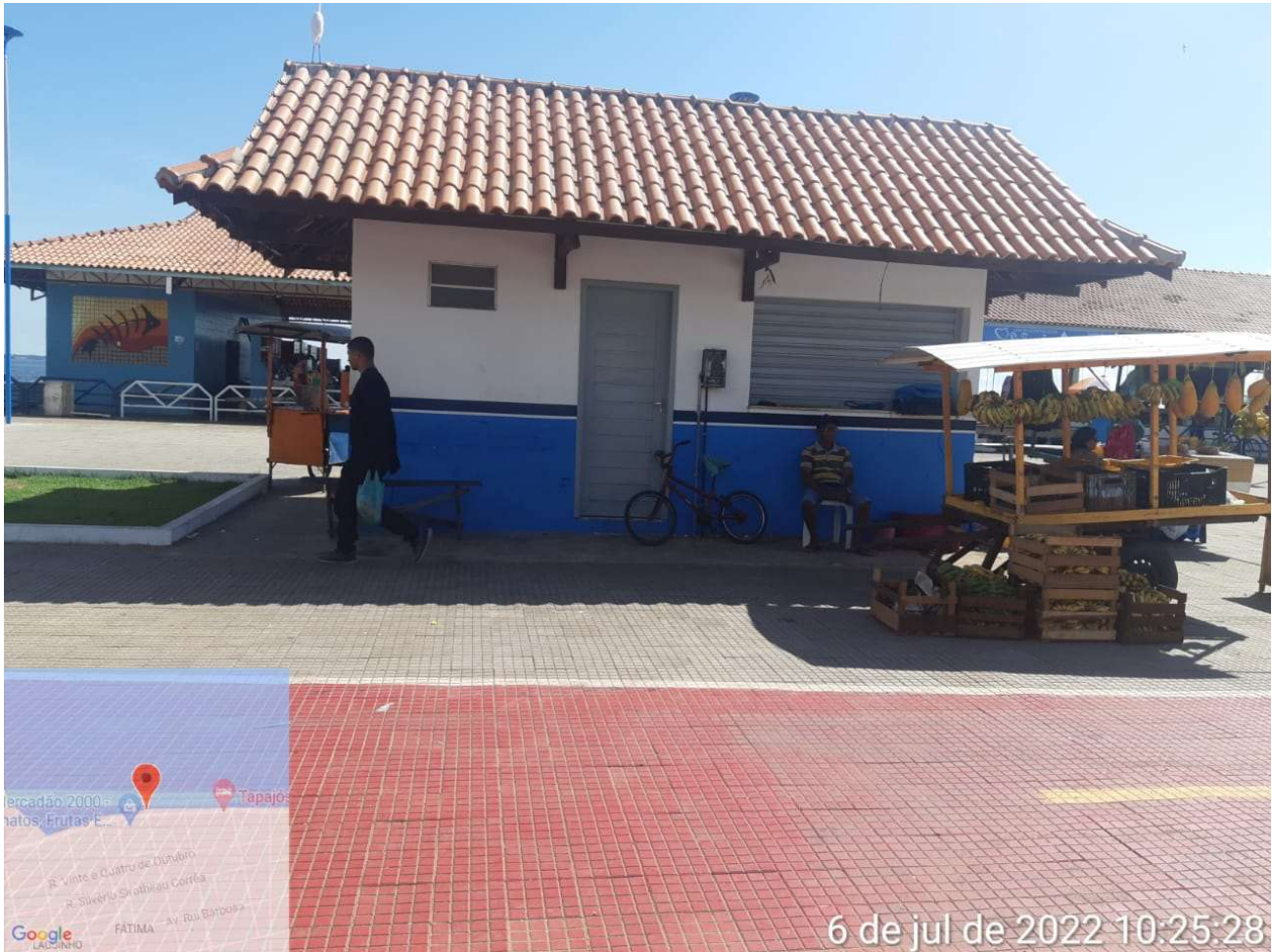
IMAGEM 01: Fachada principal do imóvel vistoriado
