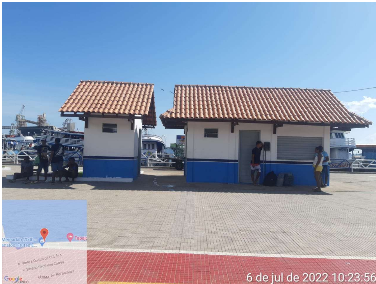
IMAGEM 01: Fachada principal do imóvel vistoriado
