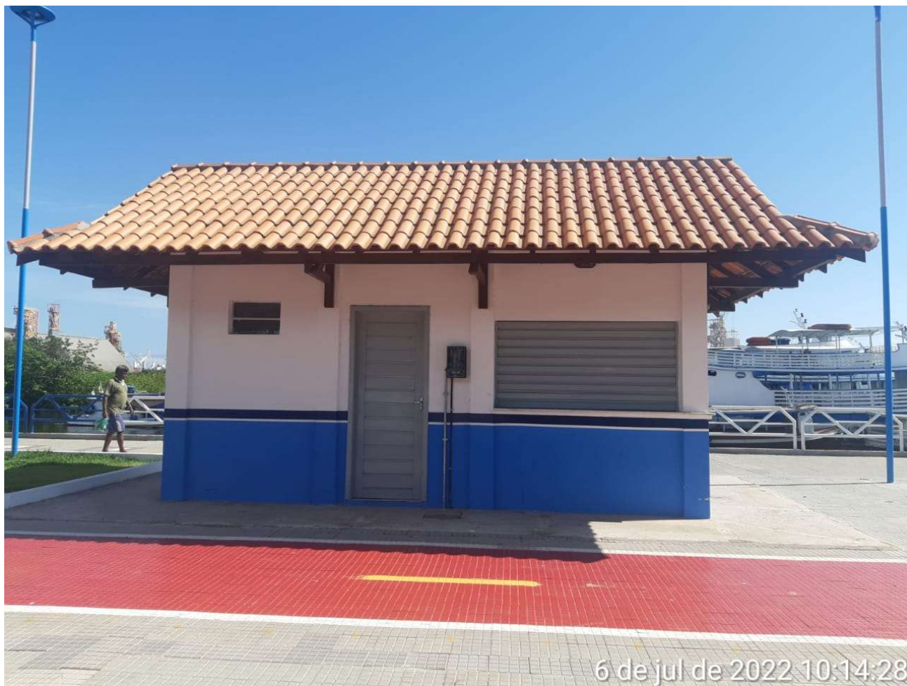
IMAGEM 01: Fachada principal do imóvel vistoriado
