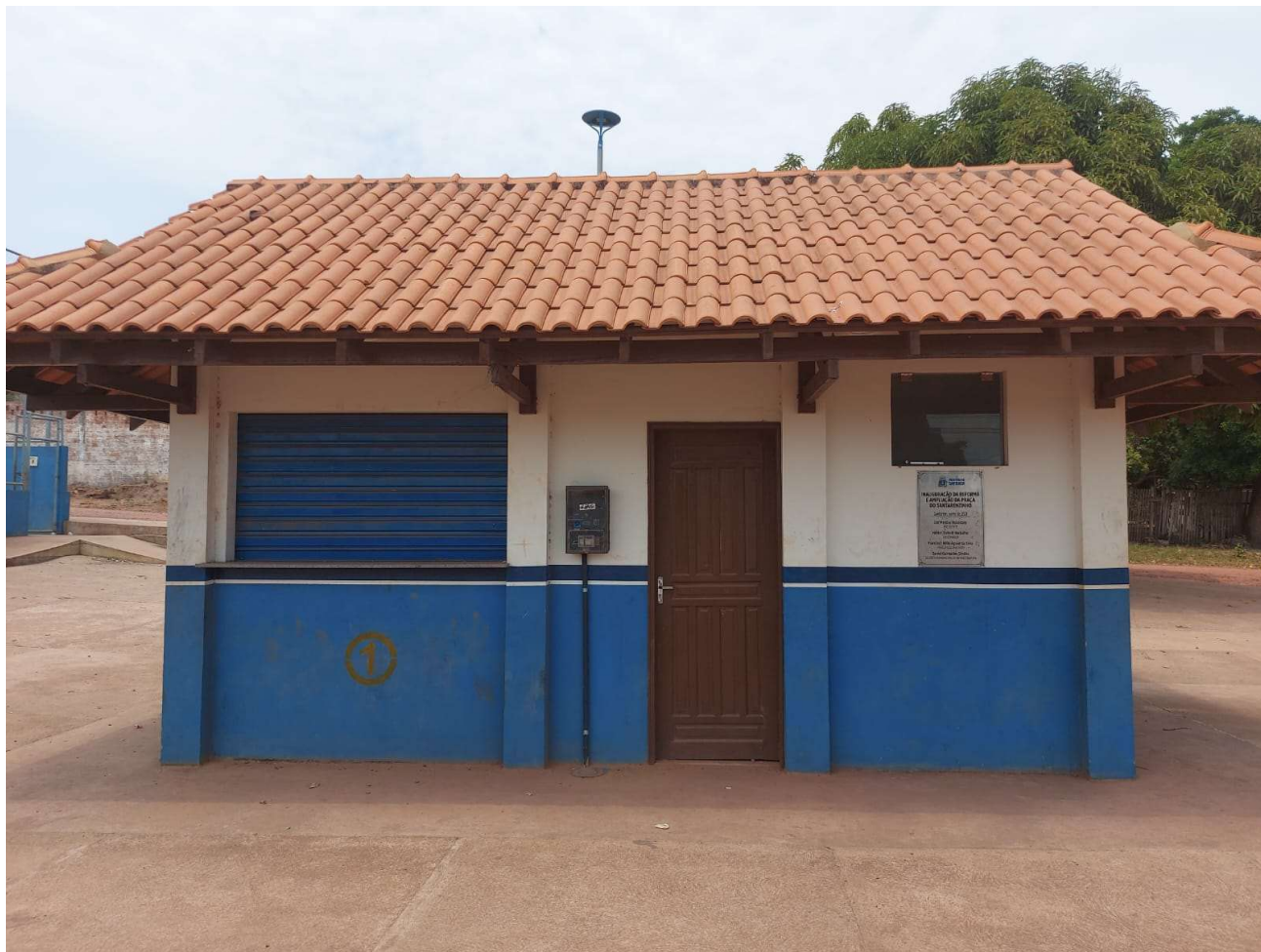
IMAGEM 01: Fachada principal do imóvel vistoriado
