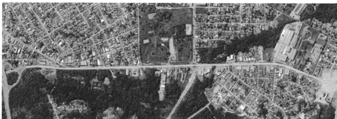
Figura 2: Duplicação da Avenida Cuiabá.
