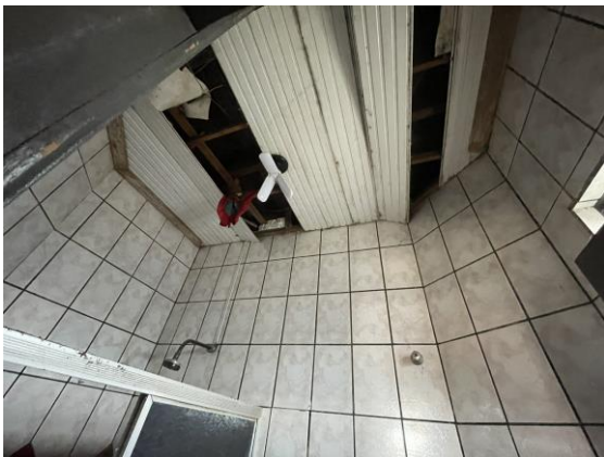
Fotos 09 e 10- Vista do forro desabado e vista do andar superior.
