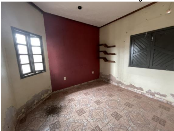
Fotos 11 e 12- Vista interna de quarto e paredes com reboco com defeito.
