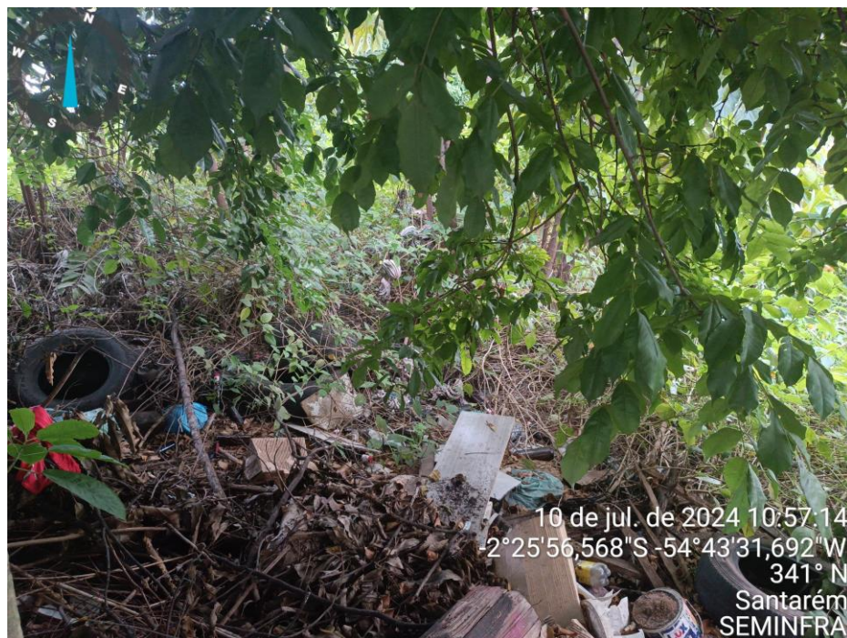
Foto 13: Área interna do local de obra. Há bastante lixo nos arredores do muro.
