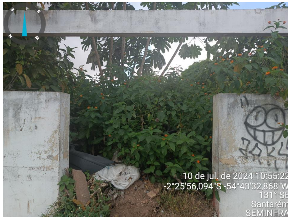
Foto 04: Outra abertura na frente do local da obra na Av. Magalhães Barata.
