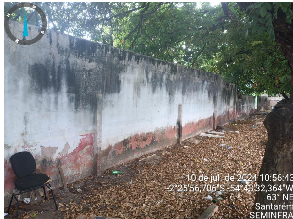
Foto 06: Muro na lateral do local da obra, na avenida Plácido de Castro.
