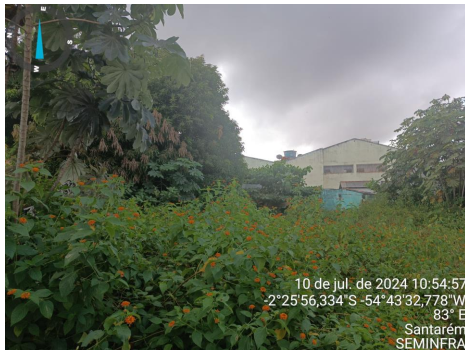
Foto 10: Área interna do local de obra. Há muita presença de vegetação alta, árvores e vegetação rasteira. Sendo difícil adentrar fundo no terreno
