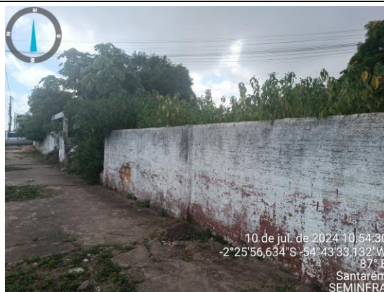
Foto 02: Frente do local da obra: Av. Magalhães Barata.
