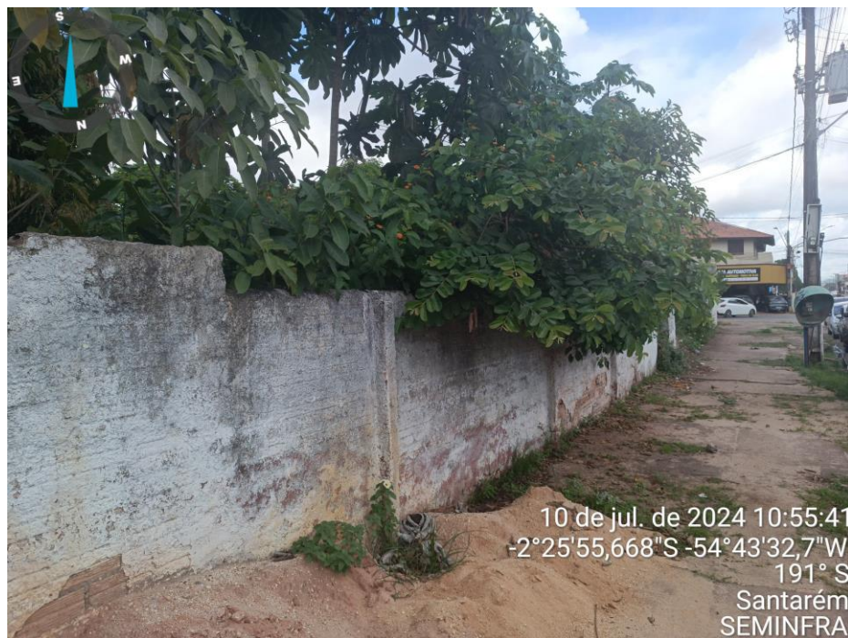
Foto 05: Muro na frente do local da obra na Av. Magalhães Barata
