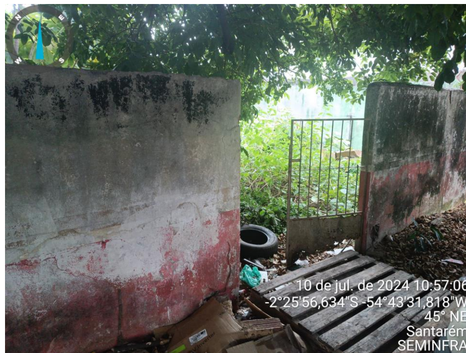
Foto 08: Outro portão menor na Lateral do local de obra, na av. Plácido de Castro
