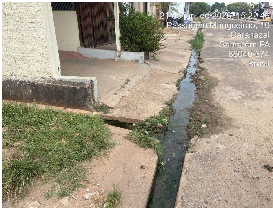
18) Foto: Passagem por onde escoa a Drenagem da Rua Monte Serrat;
