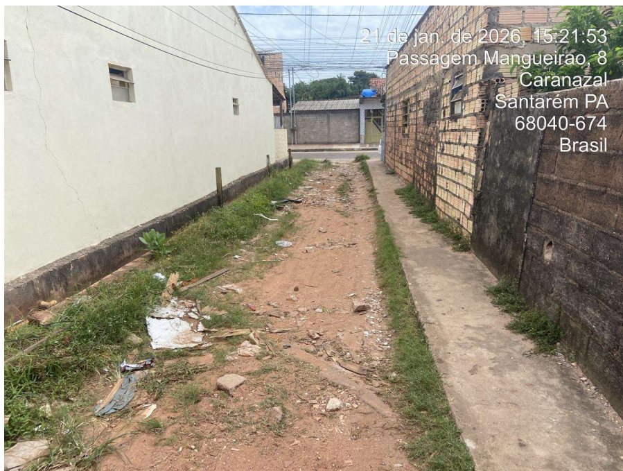
17) Foto: Passagem por onde escoa a Drenagem da Rua Monte Serrat;
