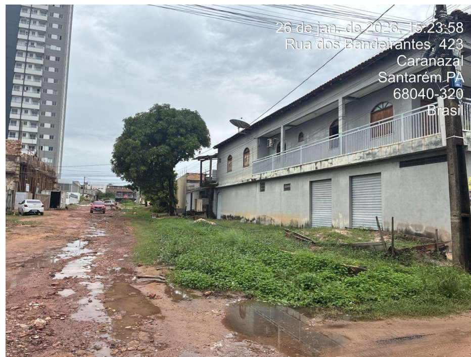
6) Foto: Rua dos Bandeirantes – trecho Caranazal;
